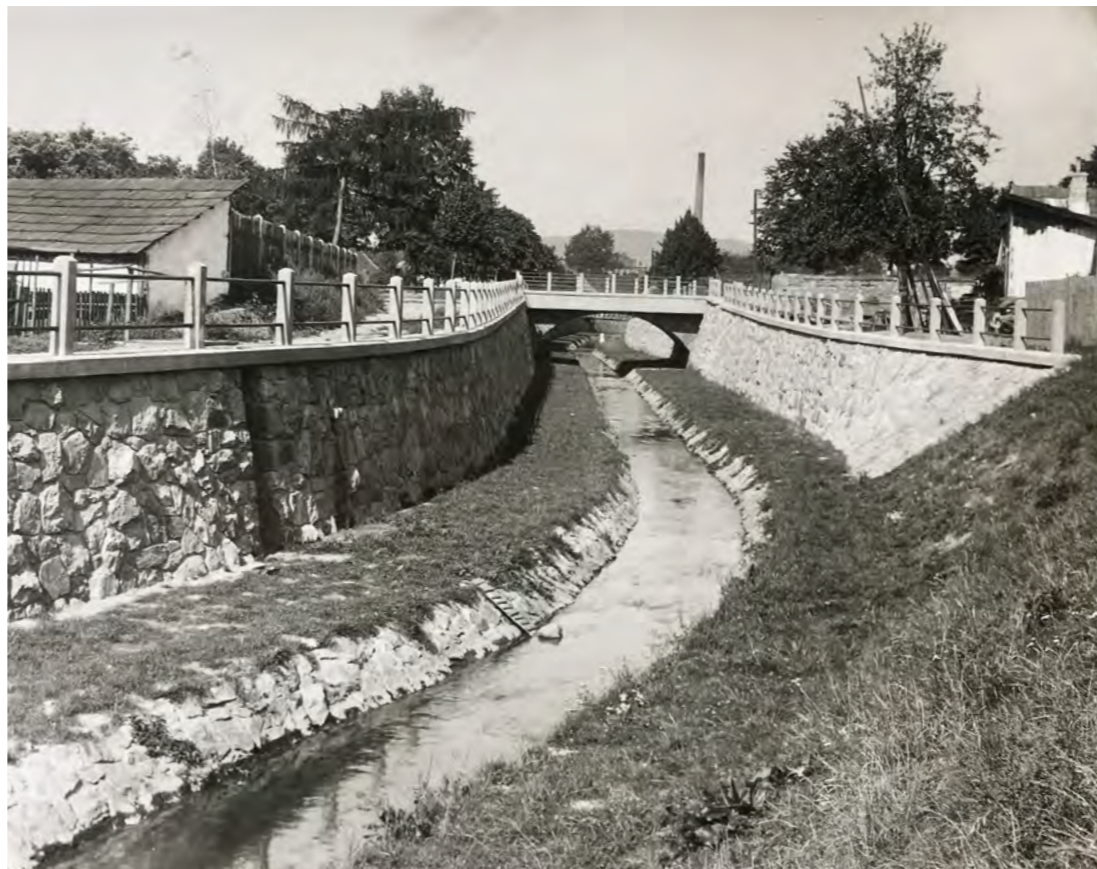
Pohled po vodě km 4.05 před úpravou. / Stav po úpravě koryta.
