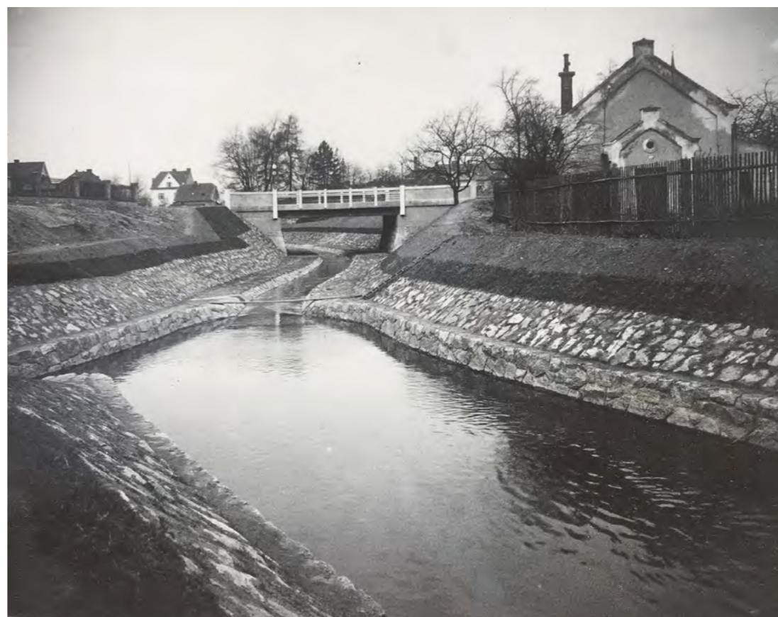
Pohled po vodě od km 4.32 na nový most.
