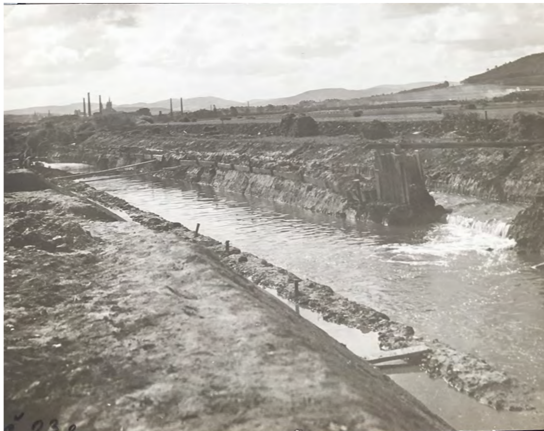
Pohled proti vodě od km 0.04 až 0.70 pod Borem. Výkop na dno kynet. / Stav červen 1931.
