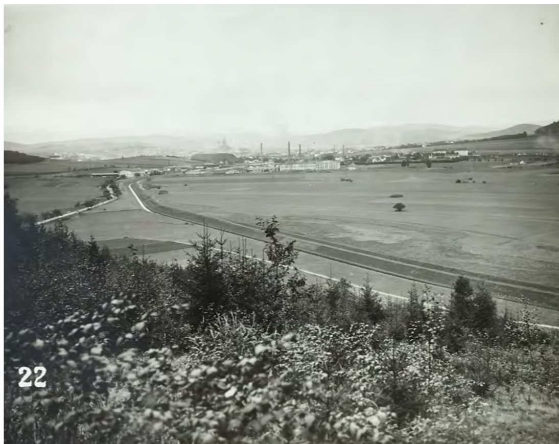
Pohled po vodě od km 1.04 až 0.94. Stav červen 1931.
