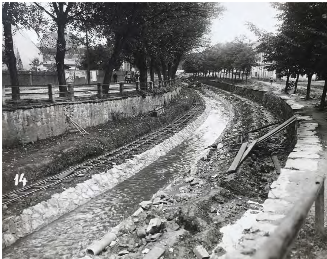
Pohled po vodě z Kolárova mostu před úpravou. / Stav 1933.
