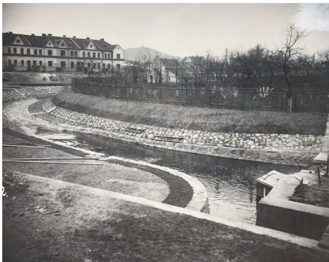
Pohled po vodě na staré koupaliště před úpravou. / Stav po úpravě - nové brodidlo.
