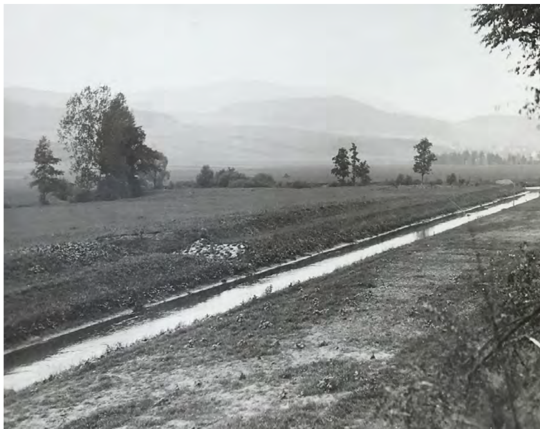
Pohled na vyústění Úhlavy před úpravou / po úpravě koryta.
