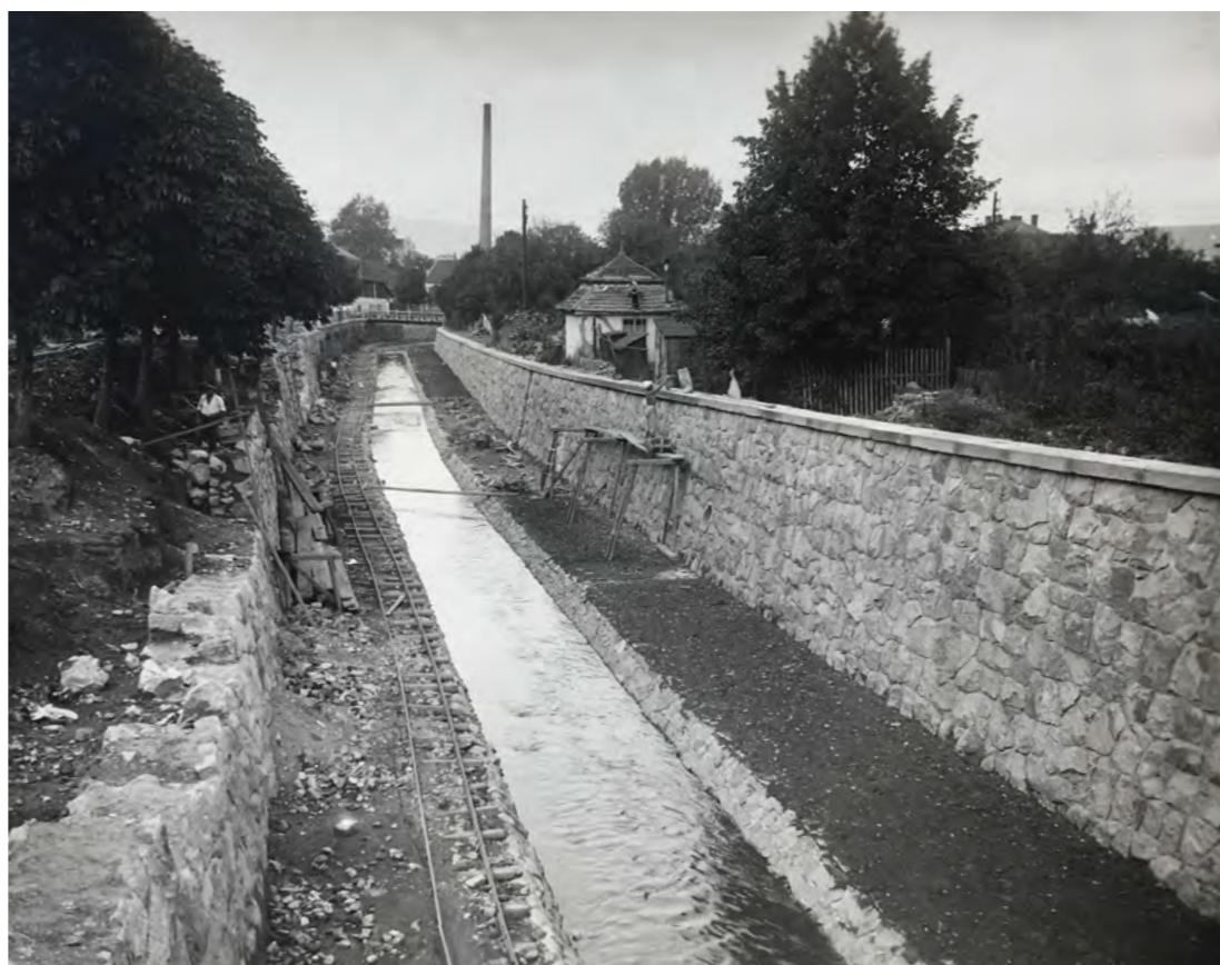
Pohled z Havlíčkova mostu od km 3.94. Před úpravou. / Stav srpen 1932
