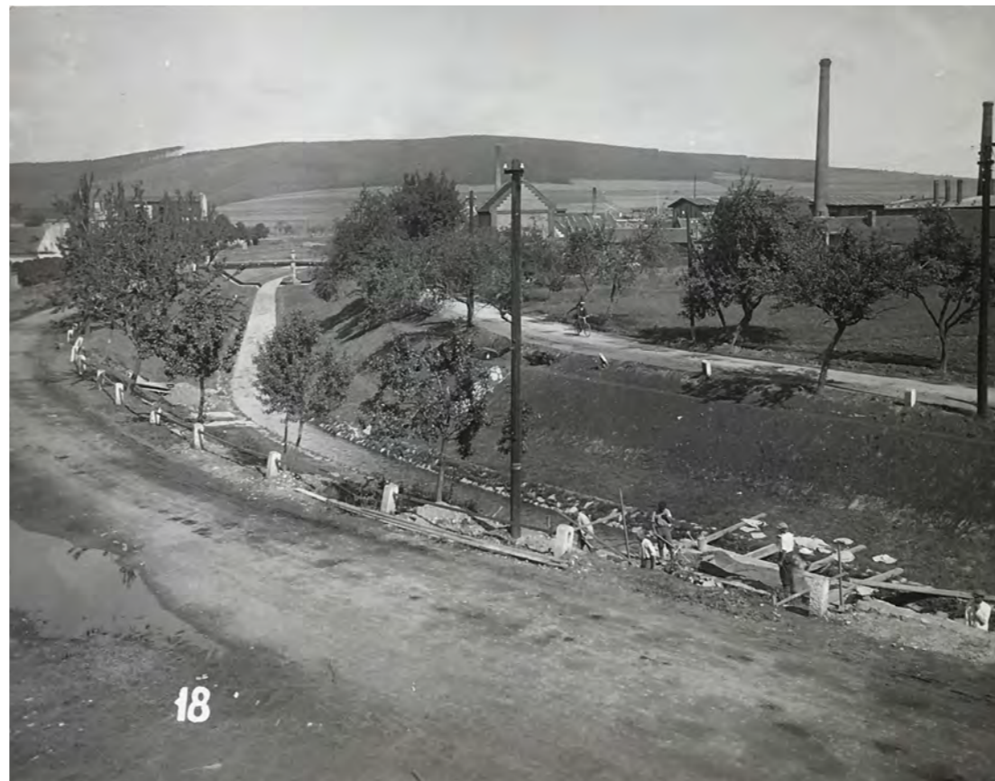
Pohled po vodě od km 2.38 až 2.20. Před úpravou. / Stav srpen 1932.
