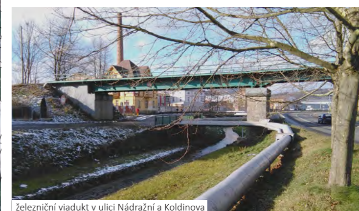
železniční viadukt v ulici Nádražní a Koldinova
