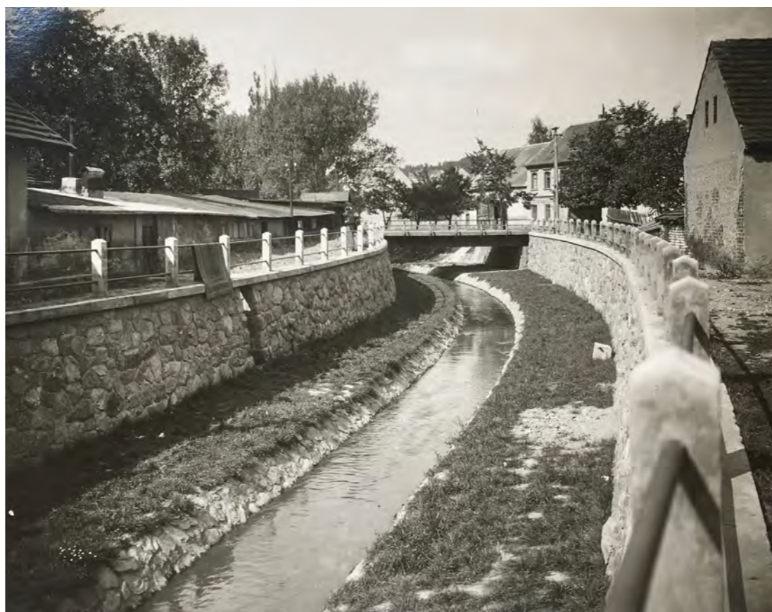
Pohled z Kolárova mostu po úpravách.
