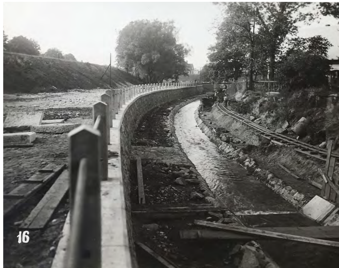
Pohled po vodě od km 2.67 až 2.56 u Pazderny. Stav před úpravou. / Stav říjen 1932.
