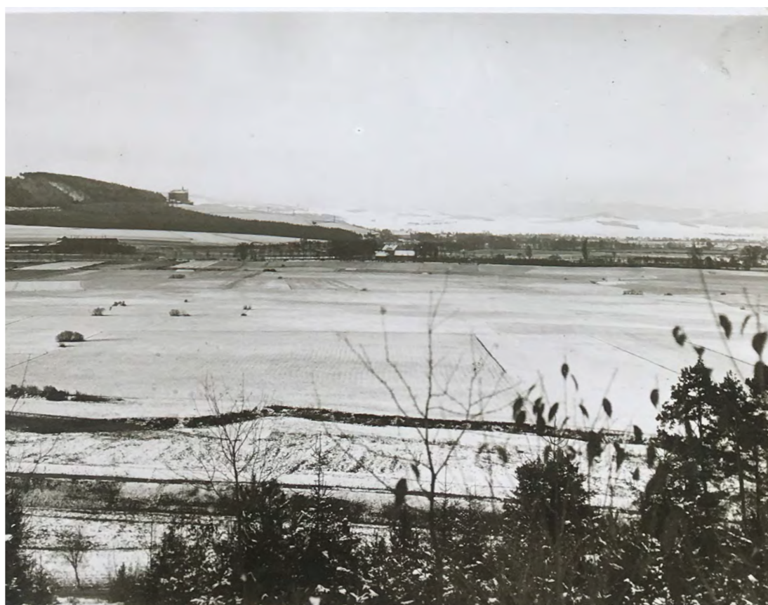
Celkový pohled ze silnice na trať v km 1.00 - 1.30
