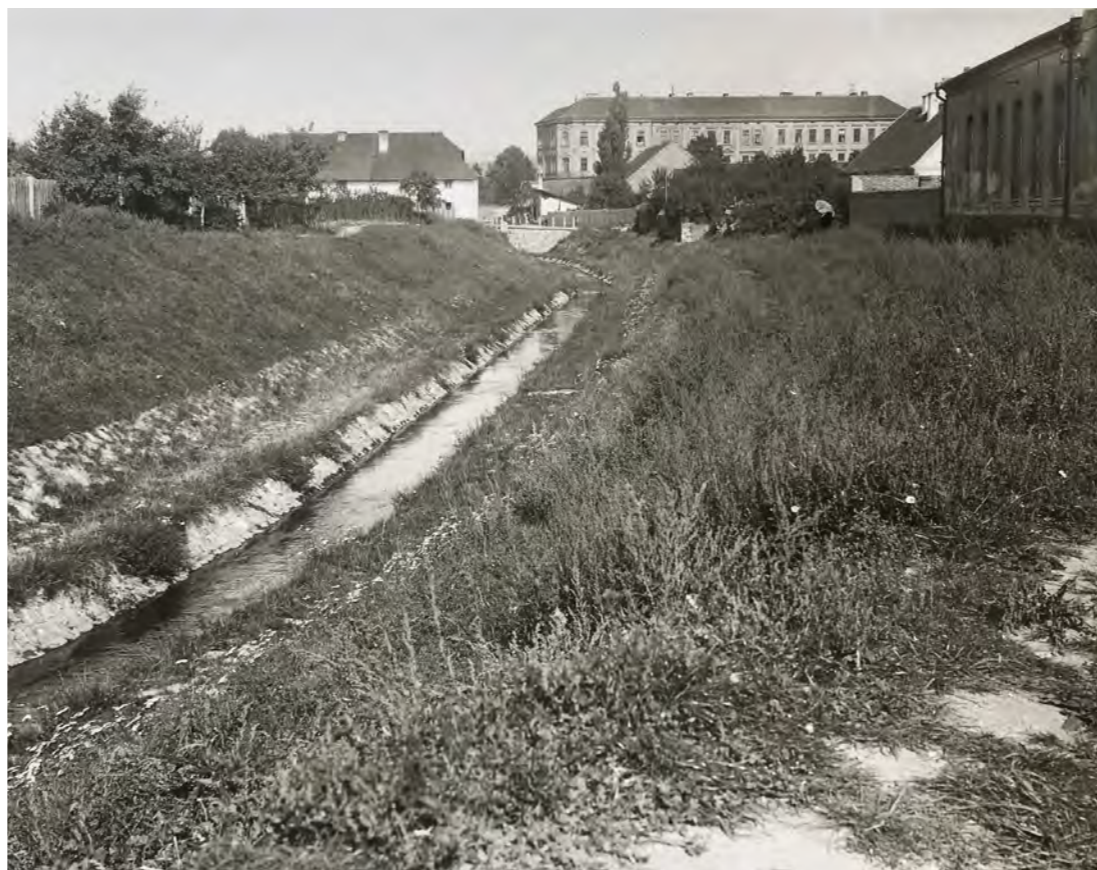
Pohled po vodě km 4.21 po opadnutí velké vody.
