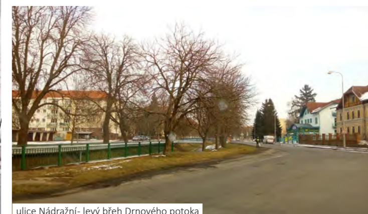
ulice Nádražní- levý břeh Drnového potoka
