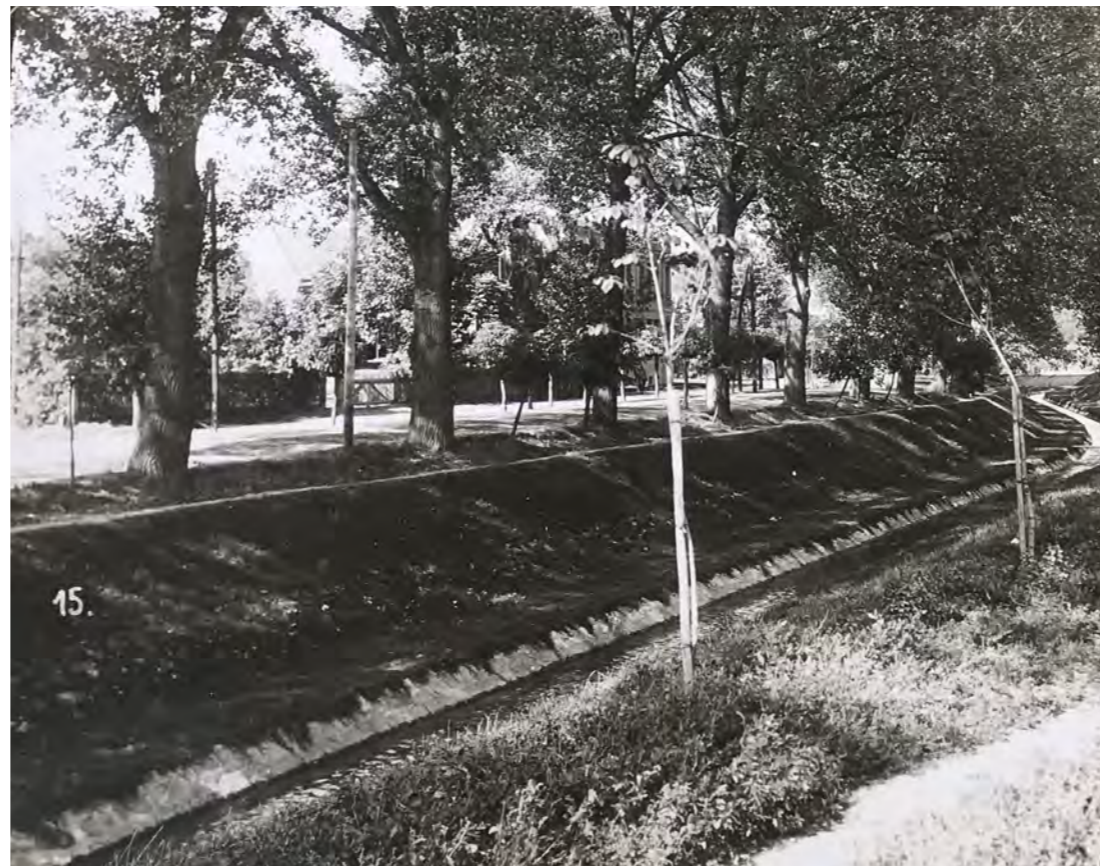
Pohled po vodě u Krajského soudu. Stav listopad 1932.
