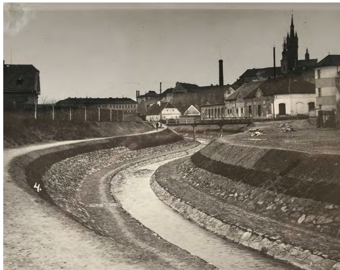
Pohled po vodě od km 4.32. Před úpravou. / Stav po úpravě koryta.
