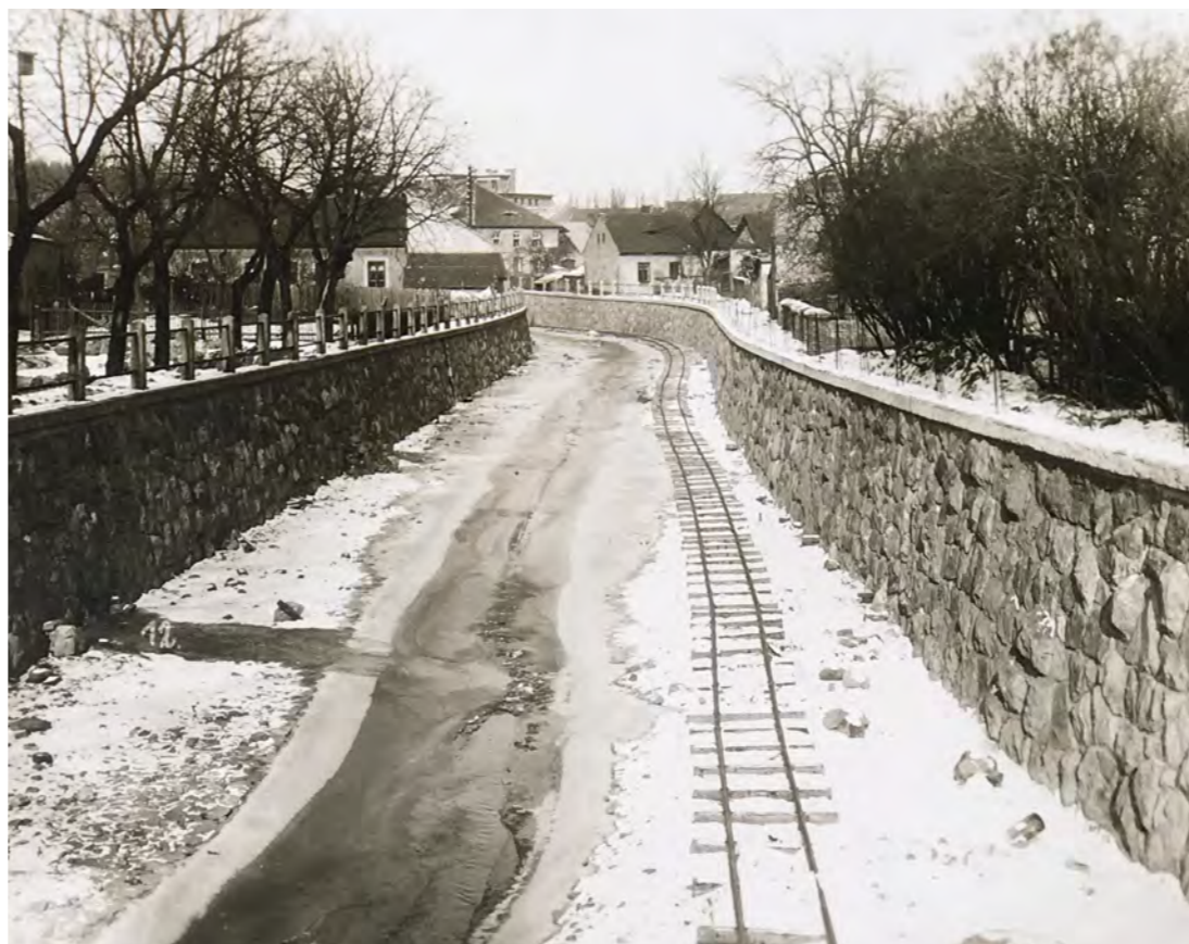
Pohled po vodě z Husova mostu. Před úpravou . / Listopad 1931.
