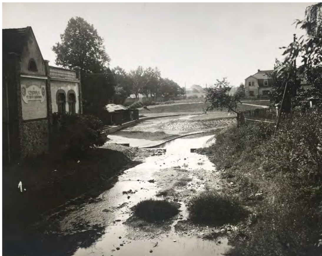
Pohled po vodě od elektrárny před úpravou. / Stav po úpravě koryta.
