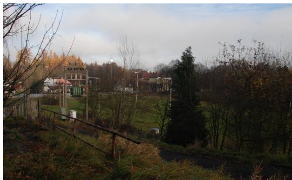
Obr.č. 101 Pohled na NY/O/4
