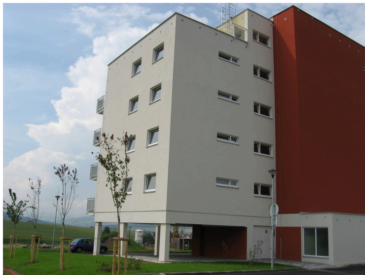
Bytový dům v Plánické ulici čp. 836.
