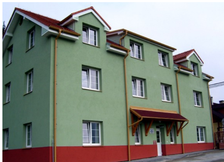
Budova ÚSP Újezdec čp. 14
