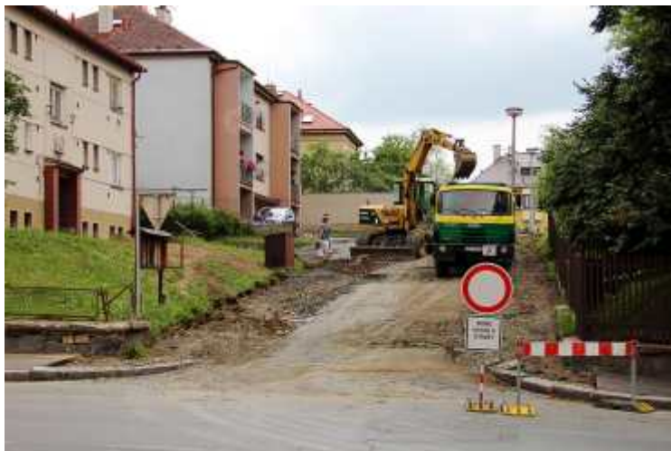
Opravy v Kličkově ulici
