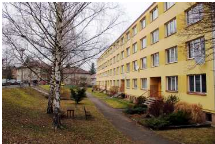
Vchody Pod Hůrkou čp. 566-569/III.
