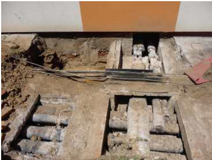
Foto starých rozvodů teplé vody a ÚT
