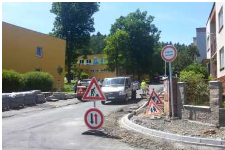
Oprava chodníku v Tolstého ulici.
