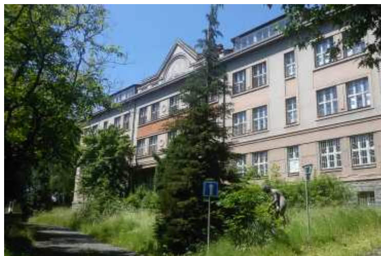
Budova bývalé porodnice.
