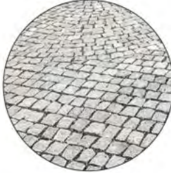
PARKOVACÍ STÁNÍ SOUČÁSTÍ VOZOVKY
