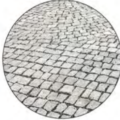
PARKOVACÍ STÁNÍ SOUČÁSTÍ VOZOVKY
