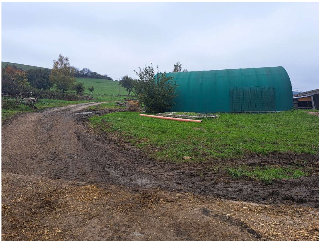
Pohled na prostor určený pro stavbu porodny
