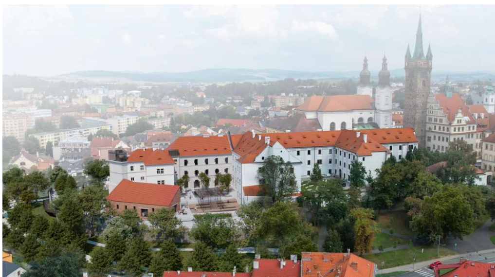
Pohled na budovu č.p. 58/I po její adaptaci, navazující na č.p. 59/I (refektář)
