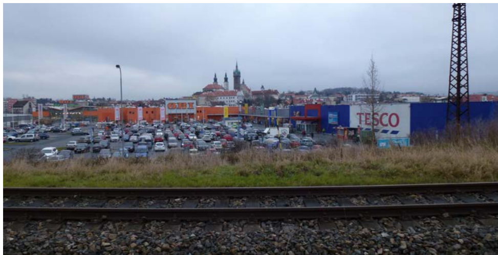
OC Škodovka - celkový pohled
