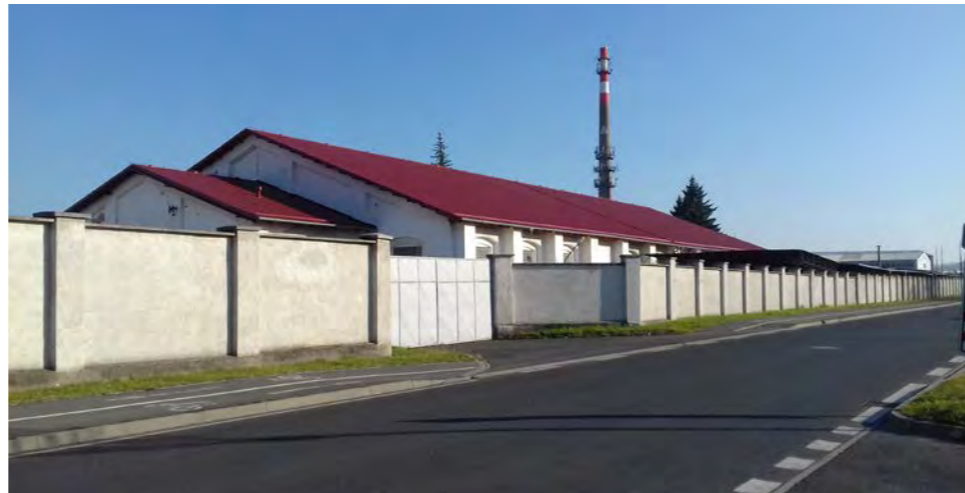
Dragounská kasárna - jízďárna, další kvalitní stavba areálu
