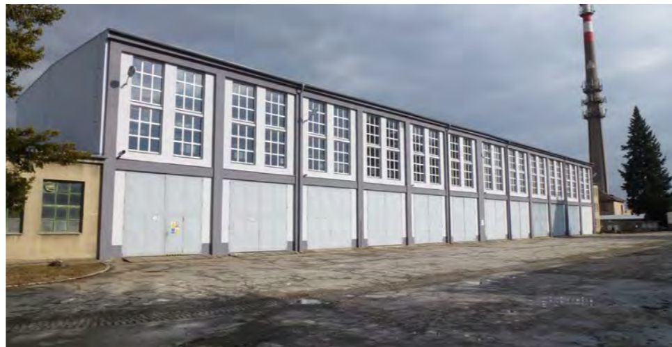
Dragounská kasárna - opravárenská hala, jedna z kvalitních staveb areálu
