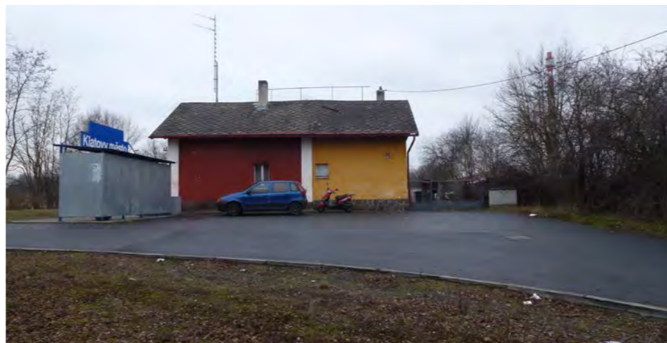
Zastávka vlaku Klatovy - město, neutěšený stav okolí, špatný přístup
