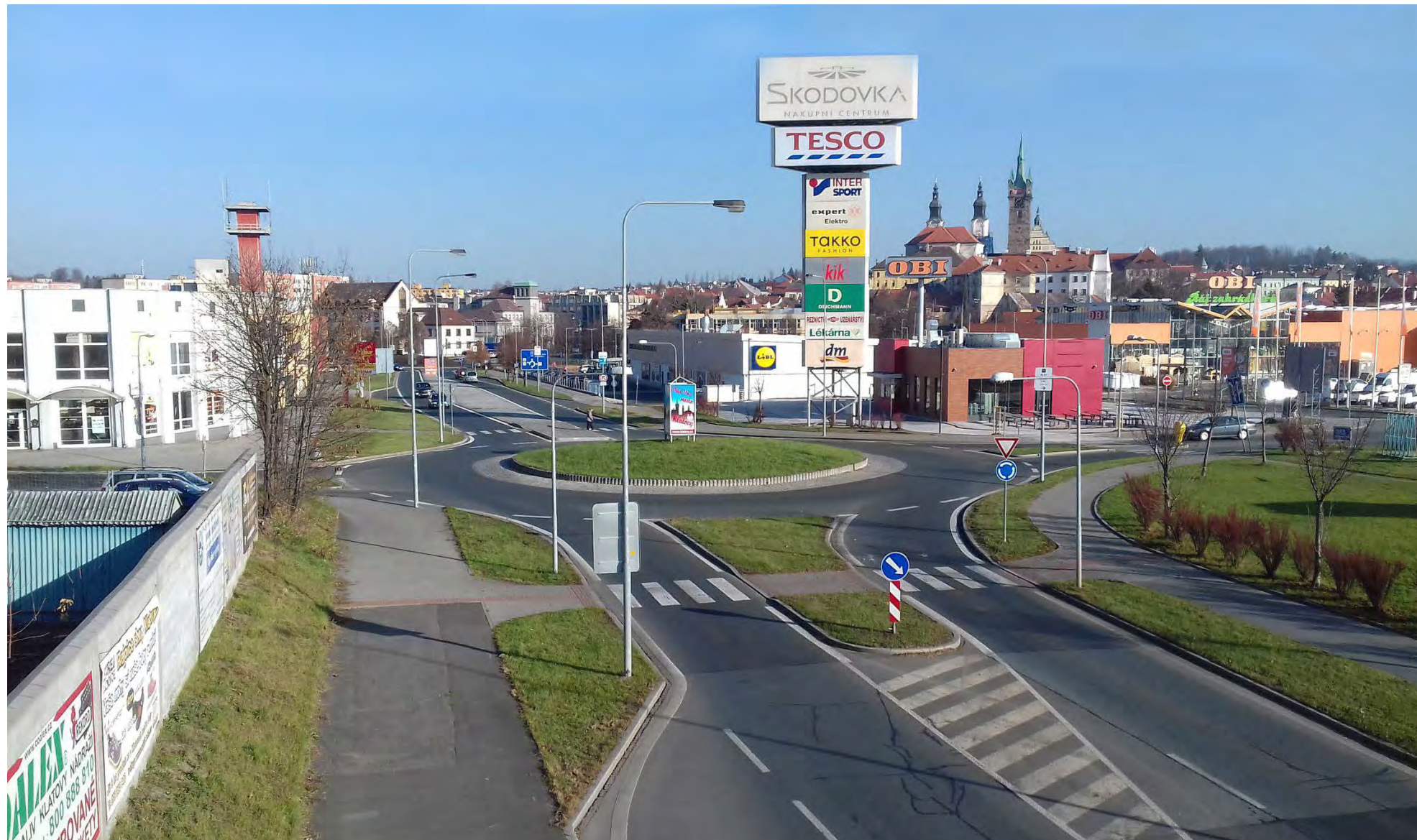
Pohled Domažlickou ulicí k východu. Plechové a kamenné centrum - stav.
