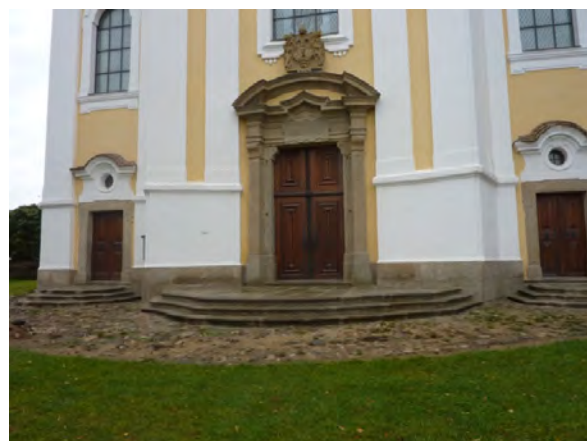
obnova kamenných schodišť na objektu kostela v Nicově
