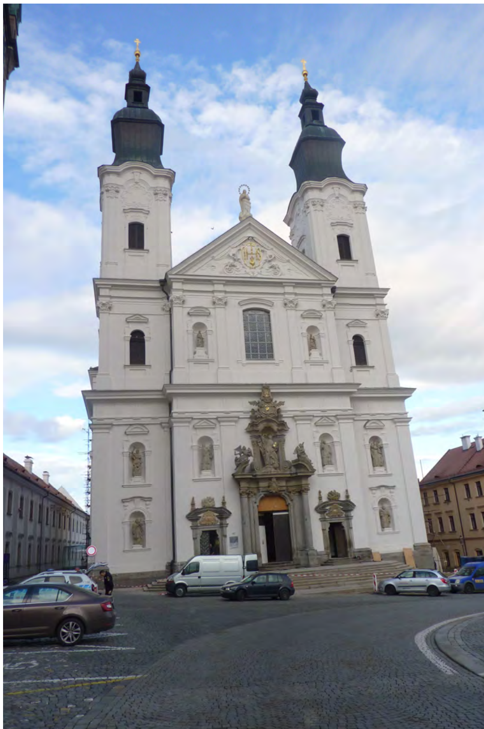
kostel Neposkvrněného početí Panny Marie – celková obnova (říjen 2019)
