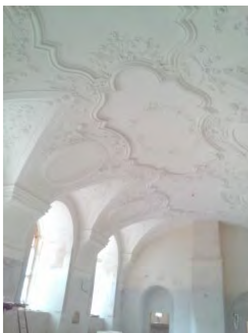
Klatovy č. p. 59/I. – stavební úpravy refektáře hrazeno z dotace PK
