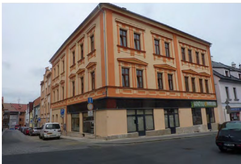
objekt č. p. 27, Pražská ul.
