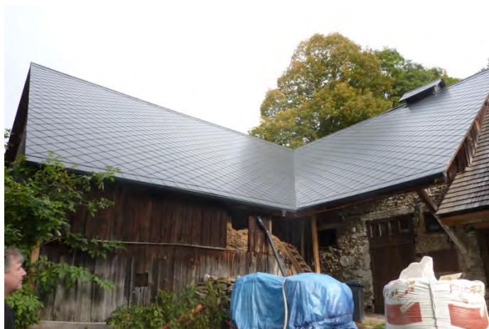
Kunkovice č. p. 6 – obnova střešního pláště II. etapa
