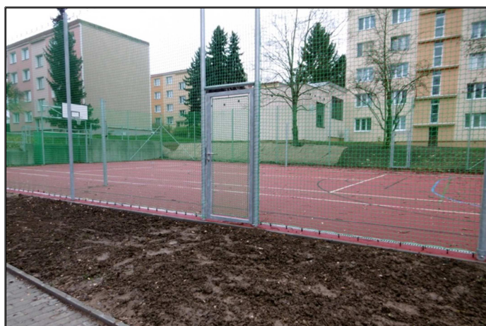
Vybudované sportovní hřiště v rámci 1. etapy projektu
