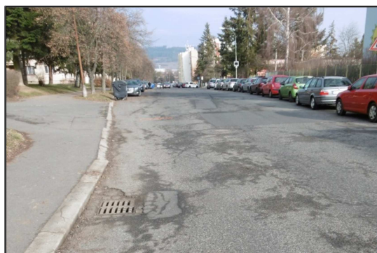
Podhůrecká ul. (před realizací, 7. etapa)
