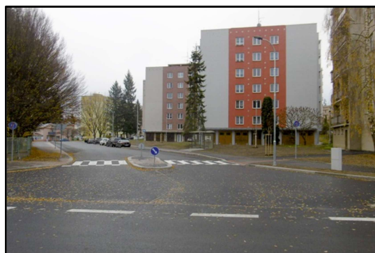
Nádražní ul. (po realizaci, 3. etapa projektu)
