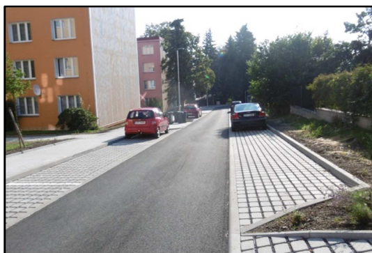
Parkovací plocha (po realizaci, 2. etapa projektu)
