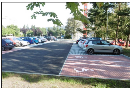
Parkovací plocha (po realizaci, 2. etapa projektu)
