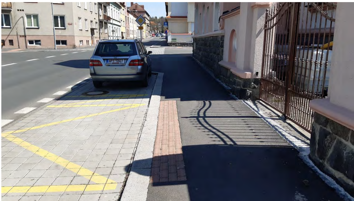
Obrázek 42 Ukázka správného provedení varovného pásu v místě vjezdu (ul. Kollárova, 2021)
