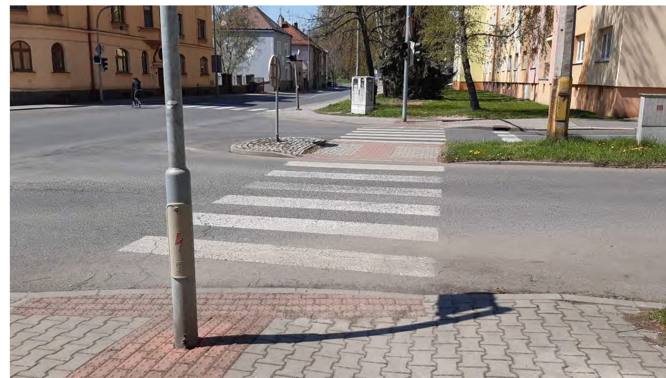
Obrázek 46 Ukázka zkrácení délky přechodu pro chodce středním dělicím ostrůvkem/pásem (ul. Dukelská, 2021)
