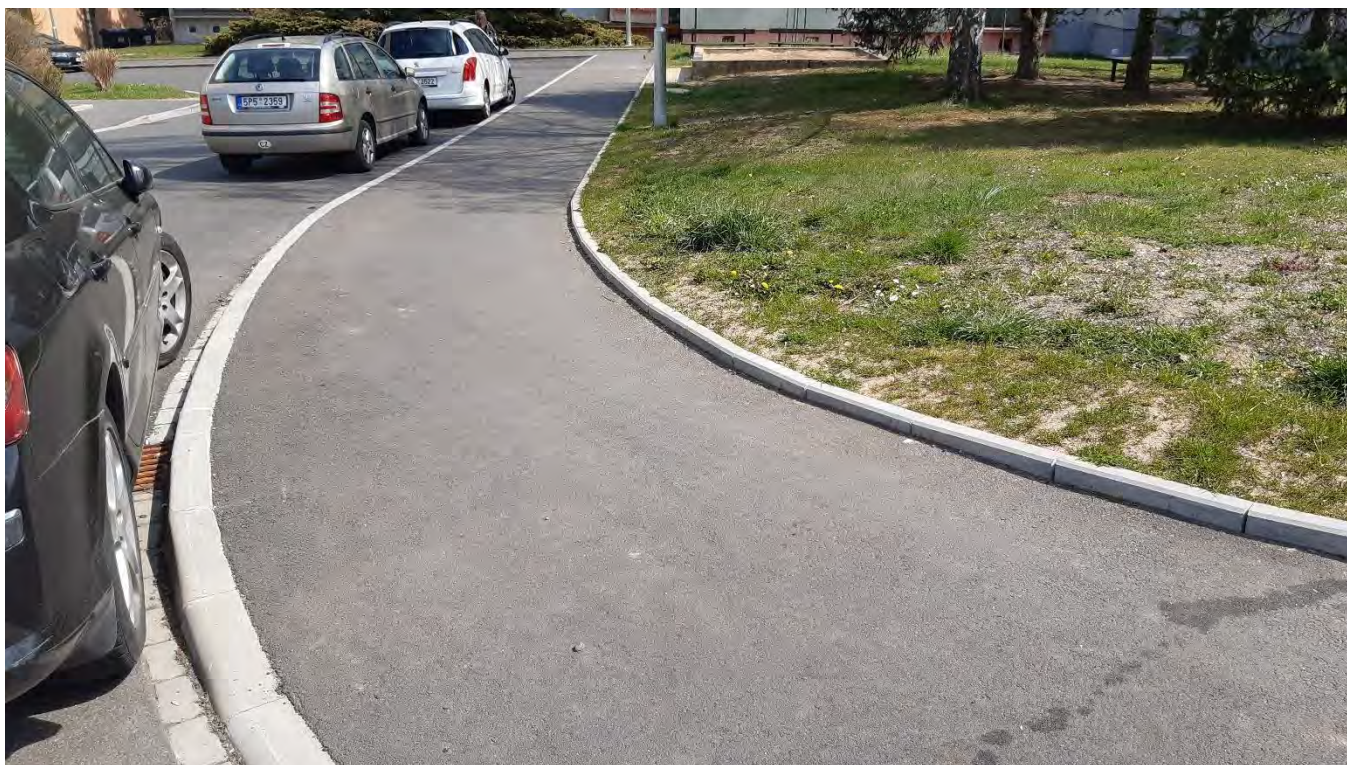
Obrázek 44 Ukázka vodící linie – obrubník s podsádkou +6 cm (ul. Zahraní, 2021)
