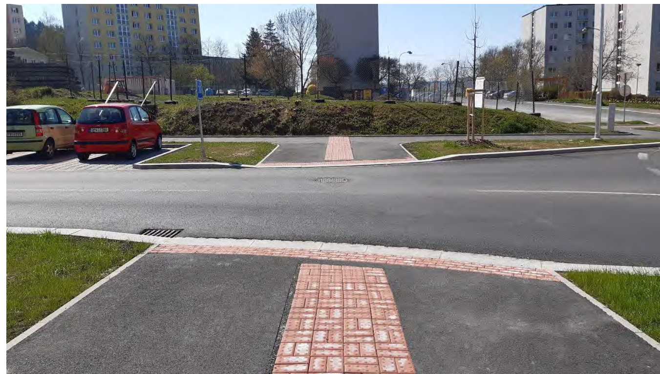
Obrázek 43 Ukázka správného provedení signálního pásu pro místo pro přecházení a snížená podsádka na +2 cm (ul. Podhůrecká, 2021)
