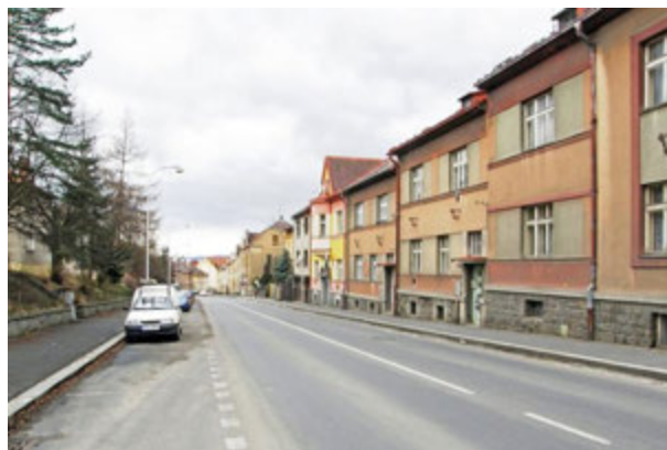
silnice II/189 – Plánická ulice v Klatovech, autor: Jan Kovařík
