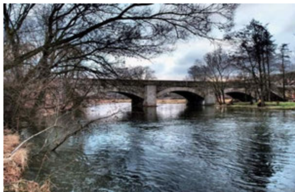
silnice I/22 – most přes Úhlavu v Beňovech
