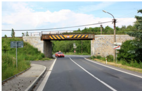
podjezd silnice I/27 pod tratí v Dehtíně (pohled od jihu)
