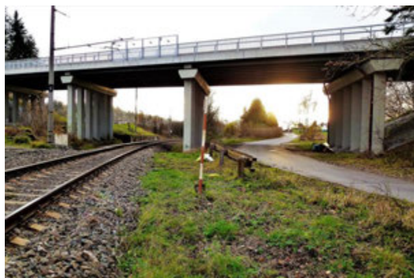
MUK na severu Klatov (most se třemi poli): nahoře silnice I/27, dole vlevo komunikace k Markytě, uprostřed železniční trať, vpravo silnice III/11766 autor fotografie: vstk
