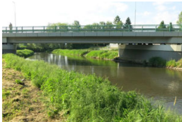
silnice II/185 – nový most přes Úhlavu v Tajanově, Autor fotografie: Ladislav Černý
