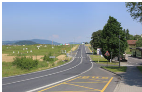
silnice I/22 v Soběticích (pohled od jihovýchodu)
