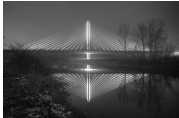
Obr. 2 – Most přes Odru na D47 ( www.asb-portal.cz )
