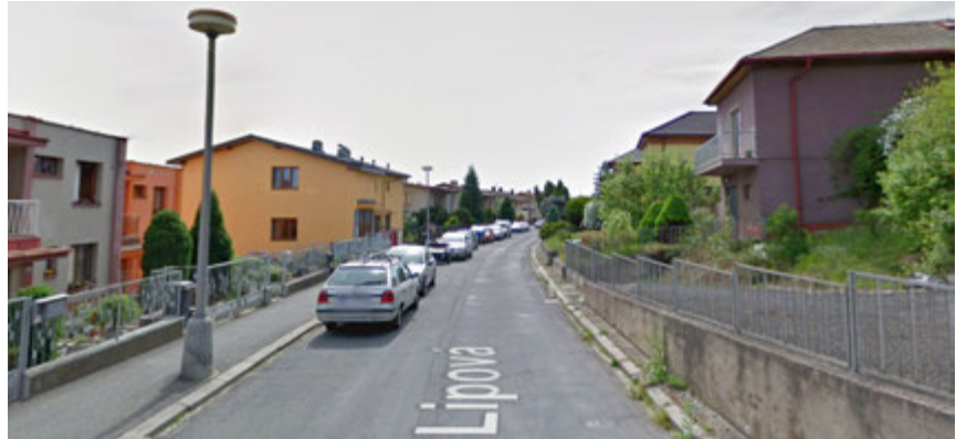
Obr. 6 – Osvětlení ulic – rezidenční čtvrti – až měření ukáže, zda je vyhovující (Google)
