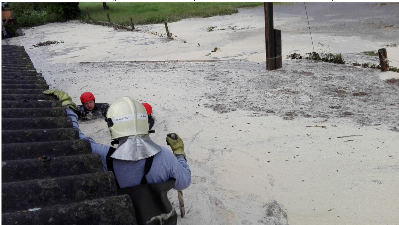
POVODŇOVÝ STAV (pohled na horskou vpusť a odtok do dešťové kanalizace)
