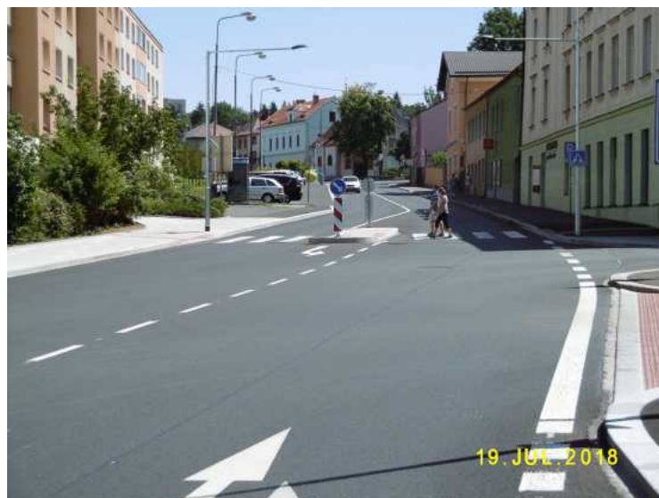
Přechod pro chodce s ochranným ostrůvkem v Dobrovského ulici.
