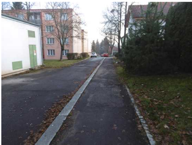
Ulice Krátká - součást RPS Pod Hůrkou II. etapa.
